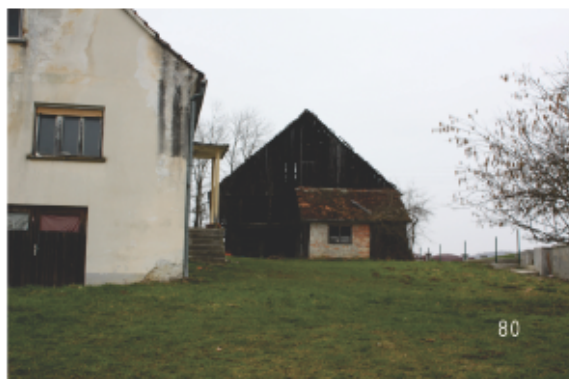
80: obstoječe stanje – stanovanjska hiša in gospodarski objekt
