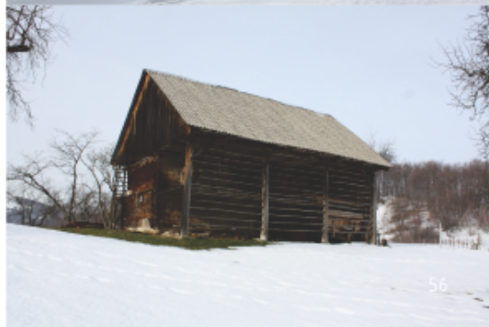
55, 56: obstoječe stanje – hiša in gospodarski objekt
