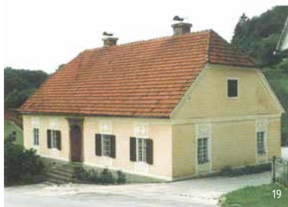
19: dvokapnica iz zareznikov, stavba v Novi cerkvi (vir: Deu, 2001)
