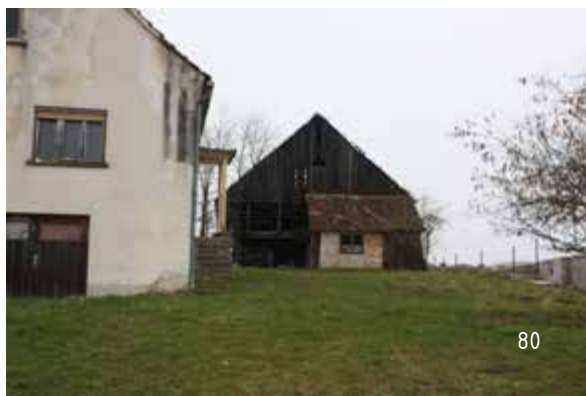
80: obstoječe stanje – stanovanjska hiša in gospodarski objekt
